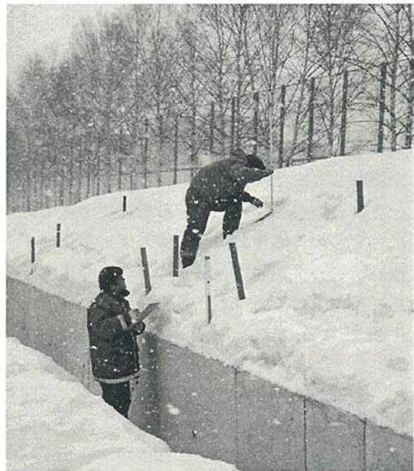
図2 北見工大構内のL字型擁壁凍上試験
