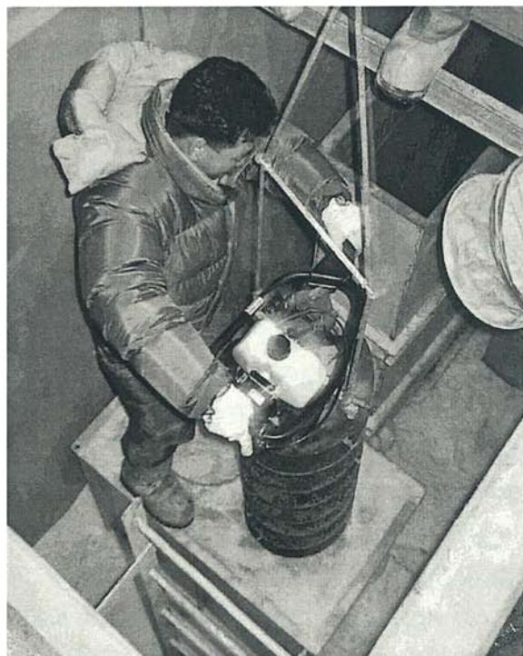
図3 海氷用大口径氷掘削機試験
