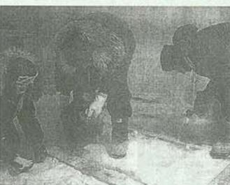
ドームより基地では、セメント代わりの氷で掘削機を凍結 (第44次南極越冬隊員の亀田さん提供)
