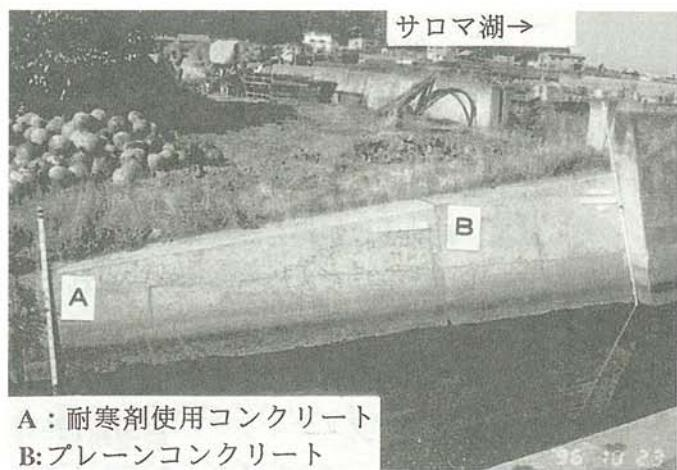
写真4 寒中コンクリートの施工
