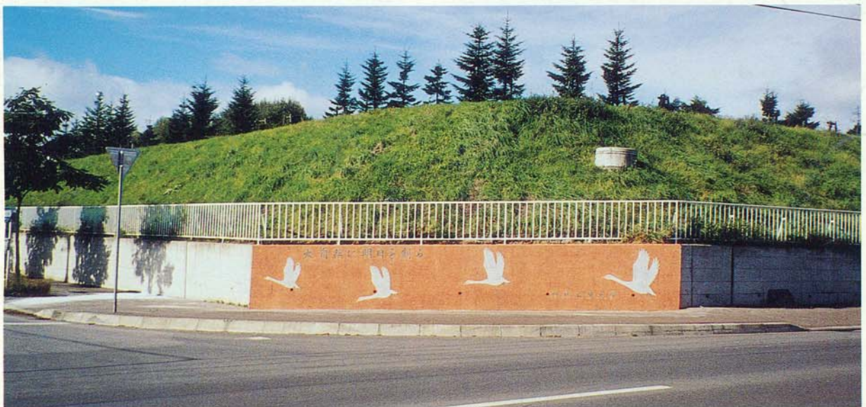
(写真説明) 溶射技術の応用によるコンクリートの機能化表面改質に関する共同研究の一環として、溶射皮膜の色調を利用した景観材料の開発を行っている。写真は、白鳥をモチーフにした壁画への応用例である。
