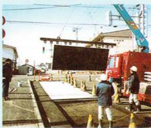
(冬季はゴムマット路面、夏季はコンクリート路面となるリバーシブルユニット)
